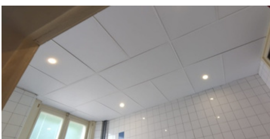
Plafondplaten en lichten in grote badkamer
