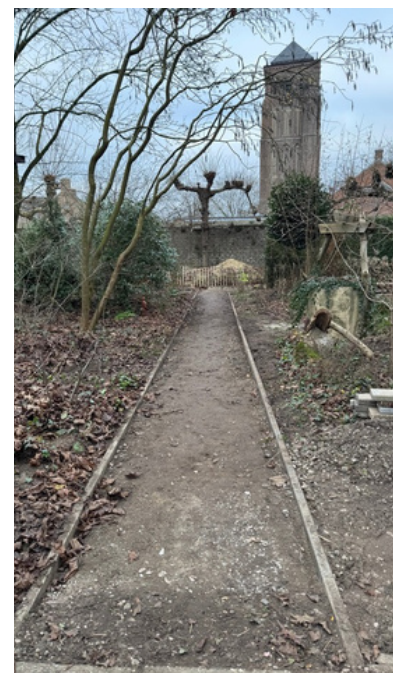
Aanleg tuinpad naar zijpoort
